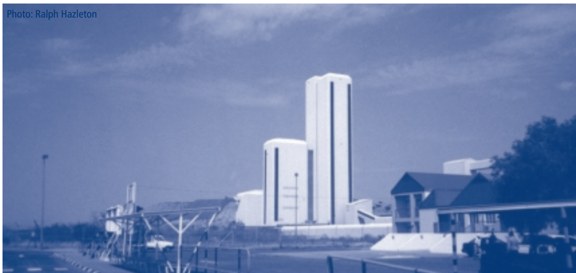
« Laquarium », l'usine de transformation à la mine Jwaneng, Botswana
