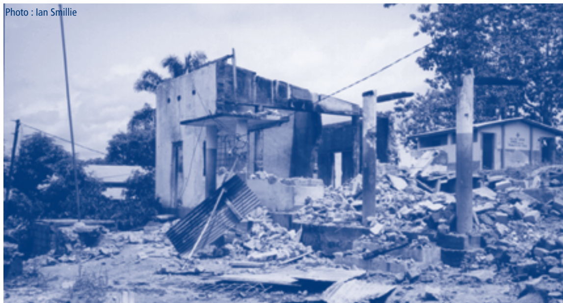
Ruines de la préfecture à Guéckedou, mai 2001
